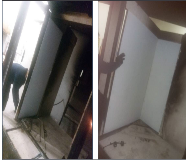
Şekil 12- 1.500x1.000 mm ve 1.500x500 mm çelik plakaların SBI odası için montajı.
