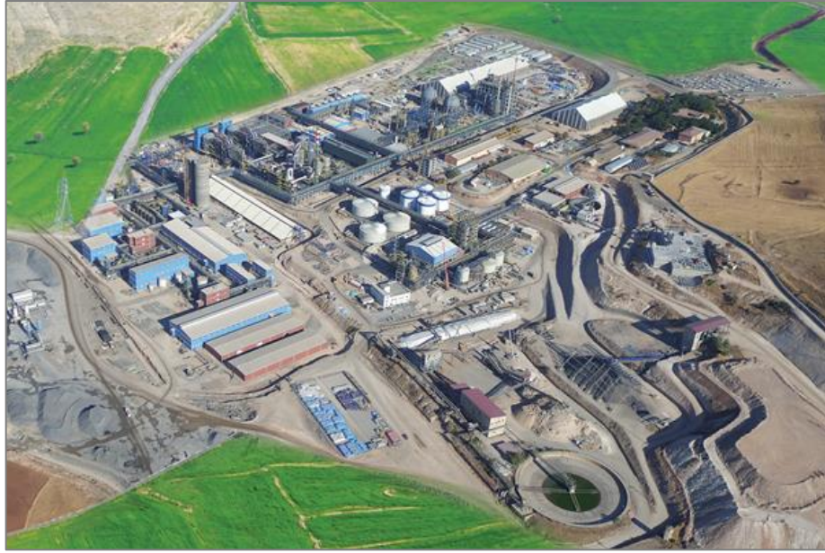
Şekil 9. Mardin-Mazıdağı Fosfat Zenginleştirme Tesisleri [12]
