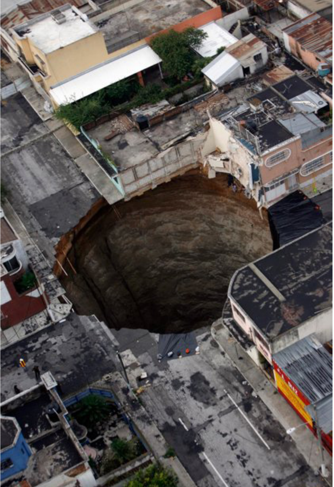
Şekil 4- Guatemala'nın aynı isimli başkentinde 2007 yılında gelişen obruk ( https://www.theguardian.com/world/2010/jun/03/guatemala-city-sinkhole ).
